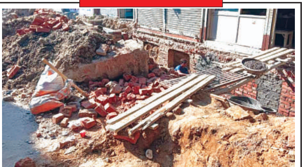
रेलवे रोड पर हो रहा नाले का निर्माण कार्य
